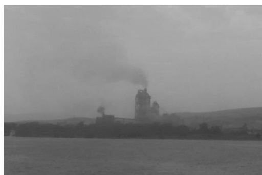
Figure 3. Les Ciments de Bizerte. Le vent souffle du secteur ESE. Cliché pris le 14/08/2020 à 16h45
