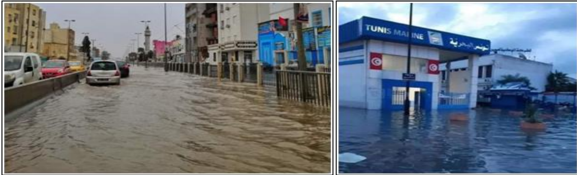
Fig. 7a et 7b : Stagnation des eaux pluviales près de la station de 20 Mars à Tunis (à droite) et à la gare du train Tunis Marine (à gauche) le 21-11-2020 gêne la circulation.
