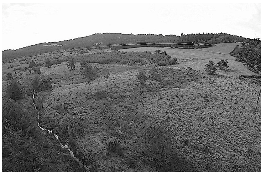
Figure 4. Restes de la digue de Sagne Redonde (Lanarce Ardèche).
